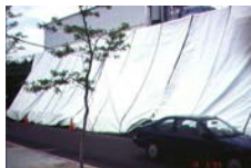
contención por atomización abrasiva Fotografía: imágenes de la eLCOOSH
