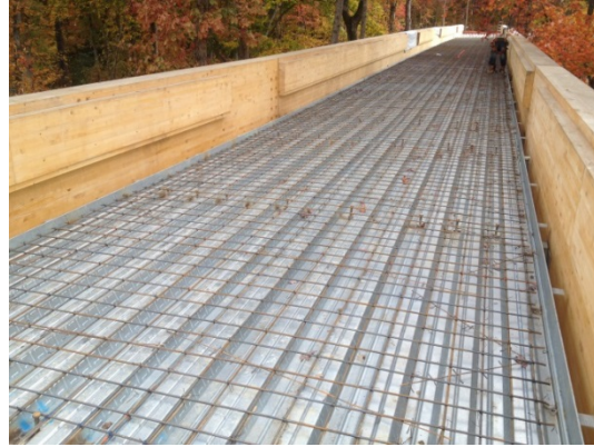
Fig. 49 – Ready for concrete pour
