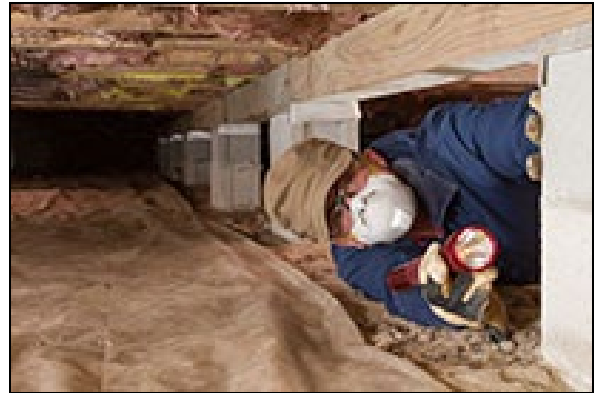
Ductos y Espacios de Tránsito a gatas
