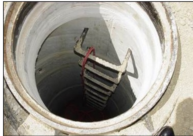
Entrada de Pozo o Alcantarilla
